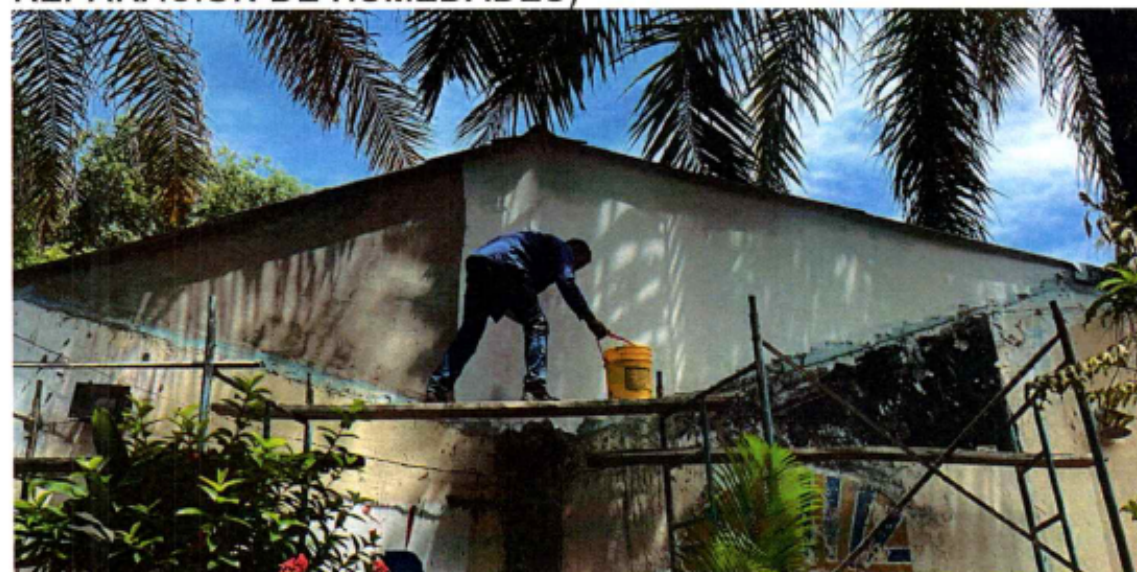
6,1 LIMPIEZA, APLICACIÓN DE ESTUCO Y LIJADO (CUCHILLAS LATERALES, REPARACION DE HUMEDADES)
