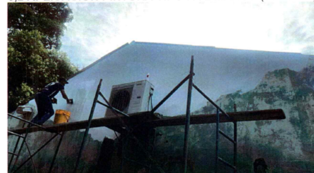
6,2 APLICACIÓN PINTURA TIPO I A 2 MANOS (cuchillas)
